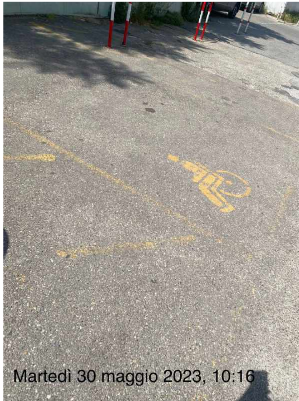
Visibilità e livello di uniformità delle strisce gialle insufficienti
