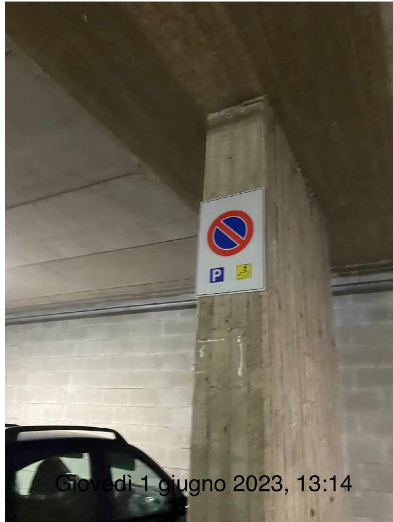
Presenza della segnaletica Verticale all'Ingresso del Park and Ride
